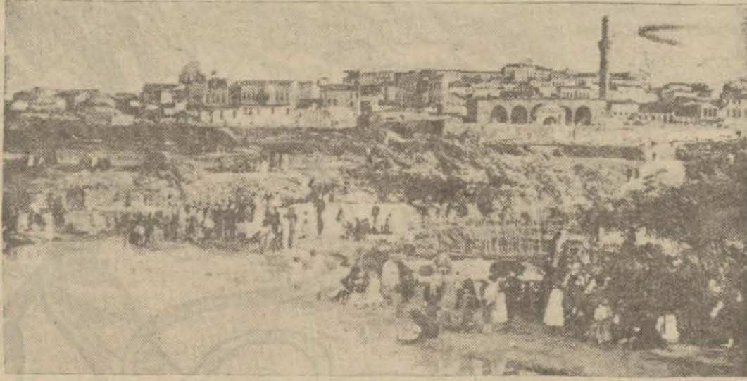
Temizlenmesine karar verilen Alleben deresi
